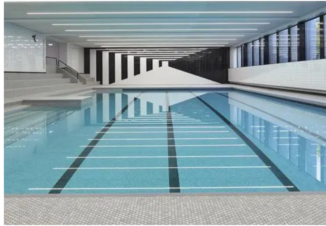
■ Otel Kulüp Binası Yüzme Havuzu
